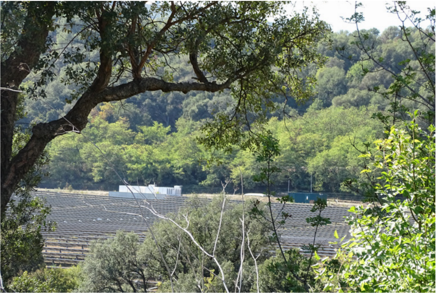
Site de Giurone panneaux photovoltaïques et stockage
